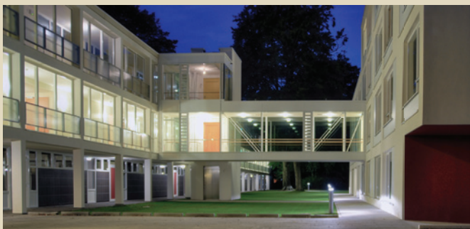
Gerontologisches Versorgungszentrum in der Marcusallee in Bremen. Revitalisierung und teilweise Neubau durch die AVW Immobilien AG. Foto: glhb.de
